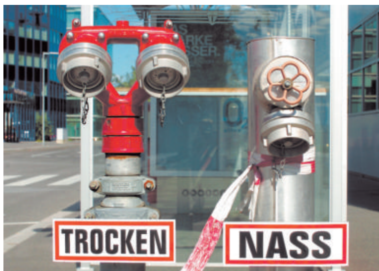
Standards sind wichtig, um Technologie zügig auf den Markt zu bringen – auch wenn es nur um Hydranten geht. Foto: Andy Urban
