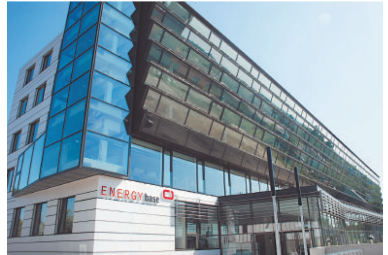
Bürobauten wie das Ende Juli in Wien-Floridsdorf eröffnete Energy Base zeigen sehr reale Energiezukunftsvisionen. Foto: WWFF
